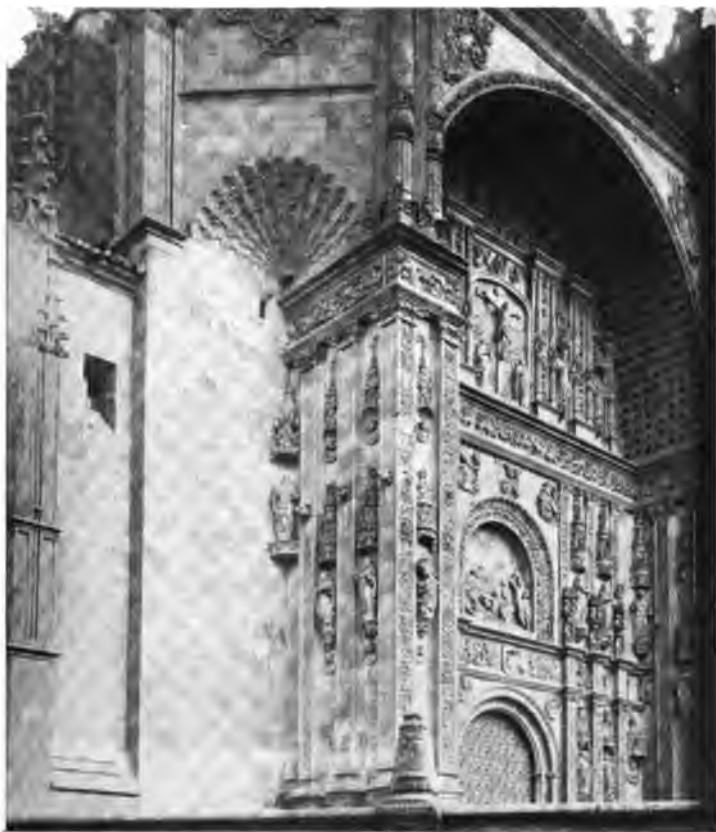
Fig. 72. — Portail du xvi e siècle à l'église San Esteban de Salamanque. Trompe reliant les contreforts pour résister à la poussée du grand arc.
